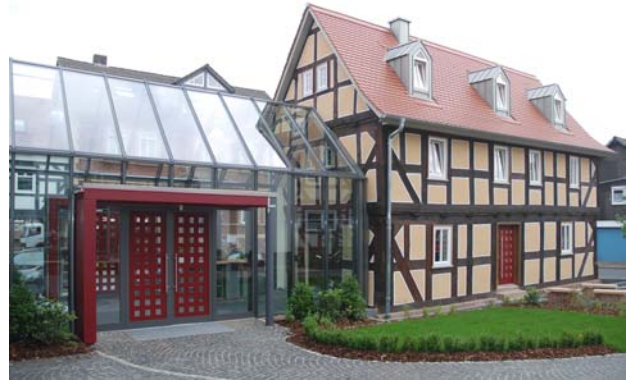
Neubau Glaszwischenbau mit saniertem Kulturdenkmal
