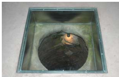
mit einer begehbaren Glasplatte abgedeckter „vorgefundener“ Brunnen
