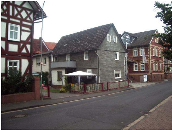
Fachwerkwohnhaus vor der Sanierung
