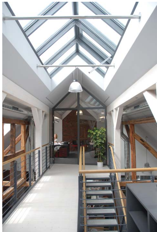
Dachraum mit Dachreiter
